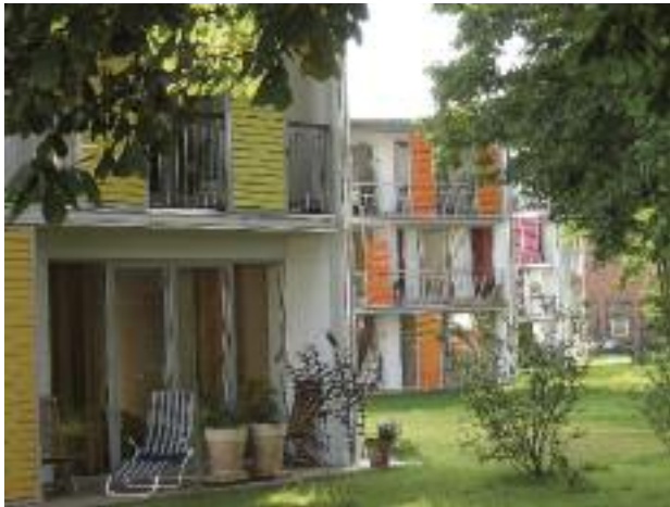
Blick in die Heilhausiedlung
